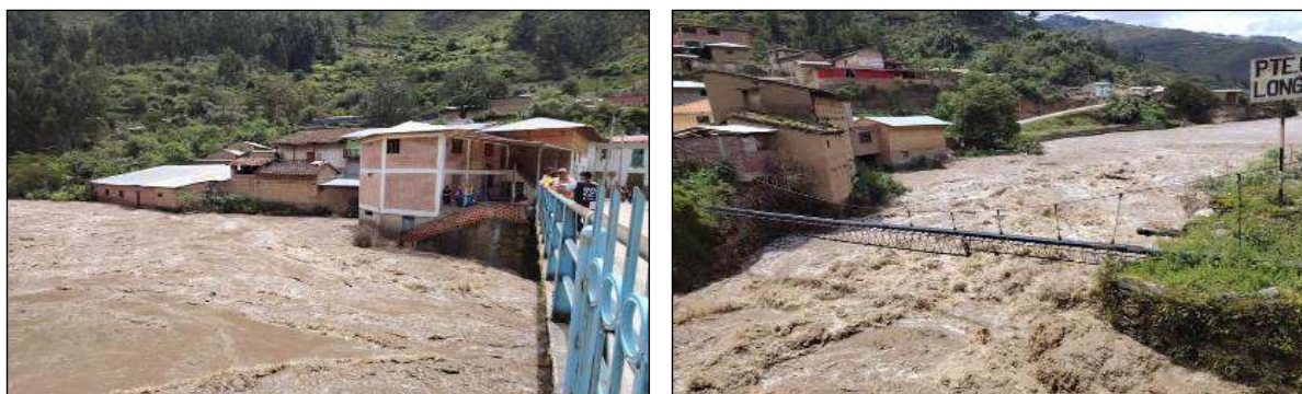
Figura 1. Muestra el desbordamiento del río Marañón en el Sector Chuquibamba 01, donde el aumento del caudal ha provocado erosión en la margen izquierda. Se observa una vivienda severamente afectada por la socavación del terreno, con riesgo de colapso, y un puente que podría estar comprometido debido al deterioro estructural causado por la crecida del río.
